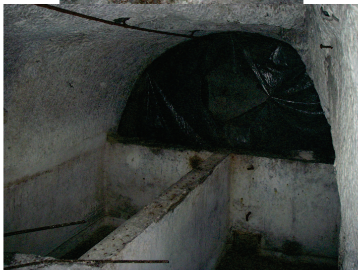
photo 6: Vestige du traitement de la craie après extraction – bassins de décantation. (carrière Lemée-Lévy-source IGC)
